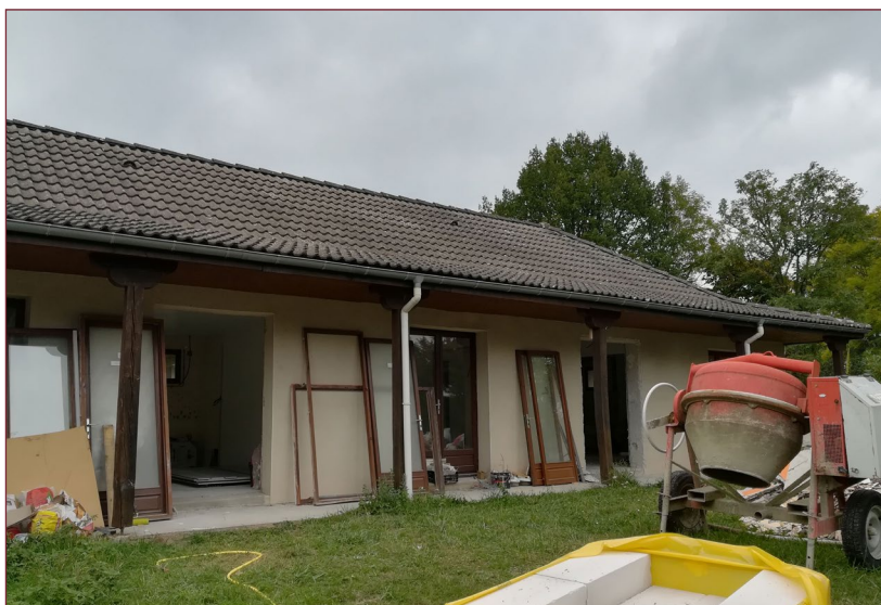
Les travaux pour les chambres adaptées se poursuivent
