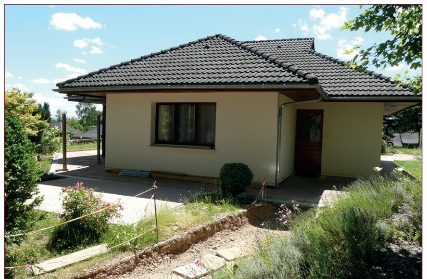
Réfection de la maison de Karmapa à l'extérieur
