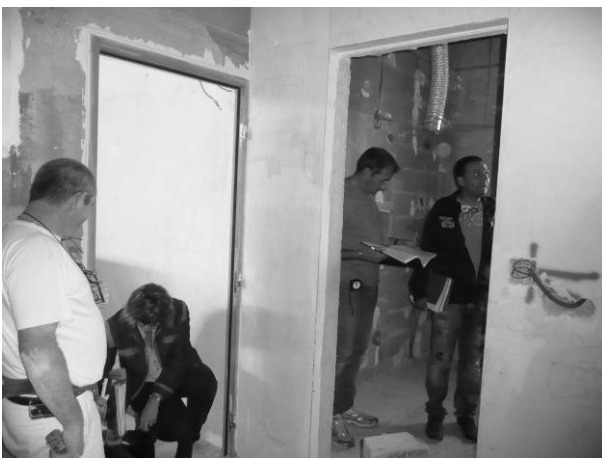
Une réunion de chantier avec les entreprises
