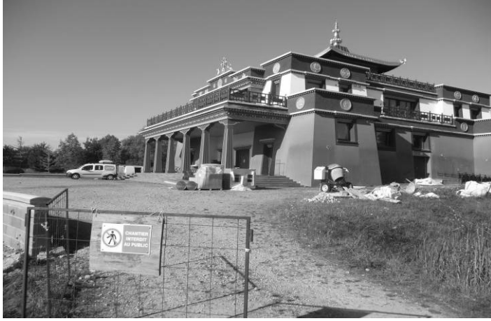
Le temple est en plein travaux !
