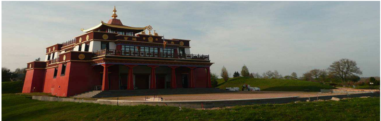
Le muret autour du temple est bien avancé
