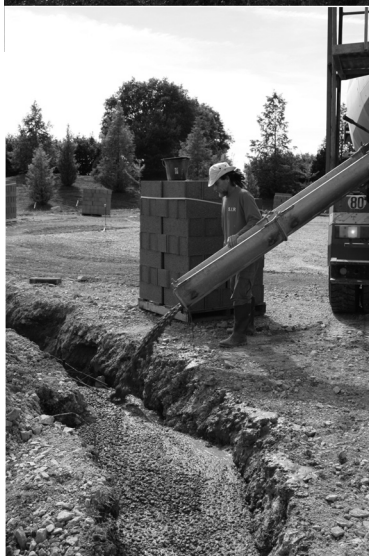
Réalisation du muret qui ceinturera l'esplanade du Temple.
